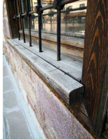
Fotoğraf 21 (a,b). Ahşap Elemanlardaki Liflenmeler (Kaynak: Pınar BAYKAL, Kültür ve Turizm Bakanlığı)
